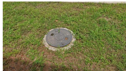
รูปที่ 3-16 ถังบำบัดน้ำเสียสำเร็จรูป
