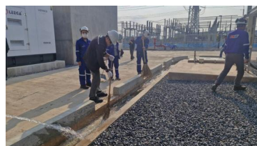
รูปที่ 3-24 การตรวจสอบและทำความสะอาดรางระบายน้ำ
