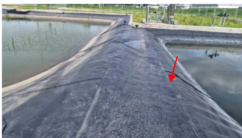
รูปที่ 3-11 การปูพื้นบ่อพักน้ำทิ้งด้วย HDPE
