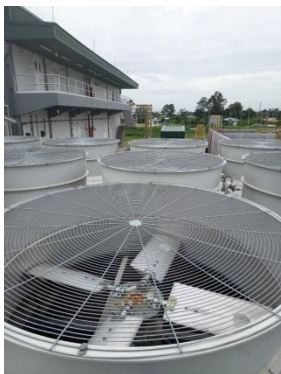
รูปที่ 3-7 ใบพัดของหน่วยหล่อเย็น
