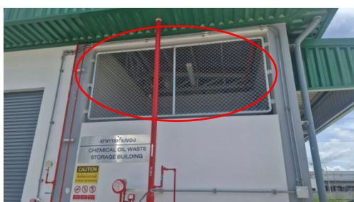
รูปที่ 3-45 ระบบระบายอากาศบริเวณ จัดเก็บสารเคมี
