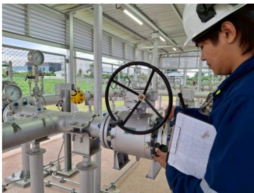
รูปที่ 3-54 การใช้ Portable Gas Detector ตรวจจับการรั่วไหลของก๊าซธรรมชาติ
