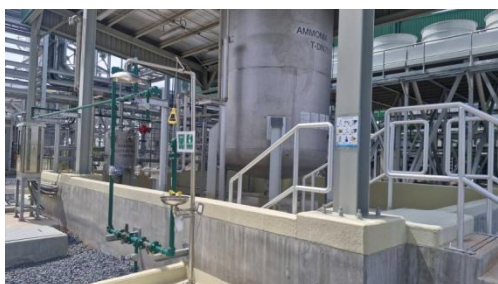
รูปที่ 3-43 ที่ล้างตา ที่ล้างมือและหน้า และฝักบัว ชำระล้างร่างกายบริเวณจัดเก็บสารเคมี
