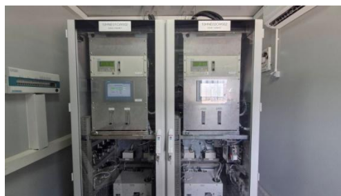
รูปที่ 3-2 ระบบตรวจวัดการระบายสารมลพิษทางอากาศจากปล่องระบายอากาศแบบต่อเนื่อง (CEMS)
