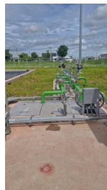
รูปที่ 3-12 บ่อตรวจสอบคุณภาพน้ำ (Inspection Pit)
