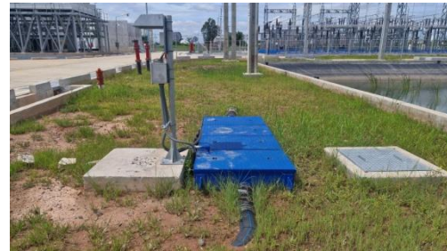
รูปที่ 3-14 บ่อแยกน้ำ/น้ำมัน (Oil Separator)
