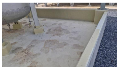
รูปที่ 3-46 คันกั้น (Dike) บริเวณจัดเก็บสารเคมี
