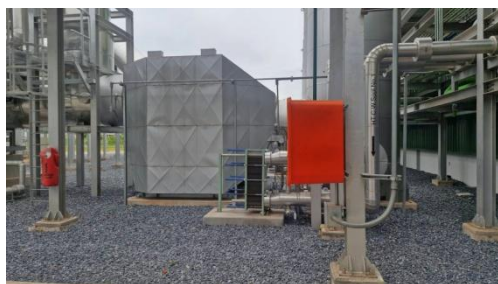
รูปที่ 3-1 ระบบ Selective Catalytic Reduction (SCR)
